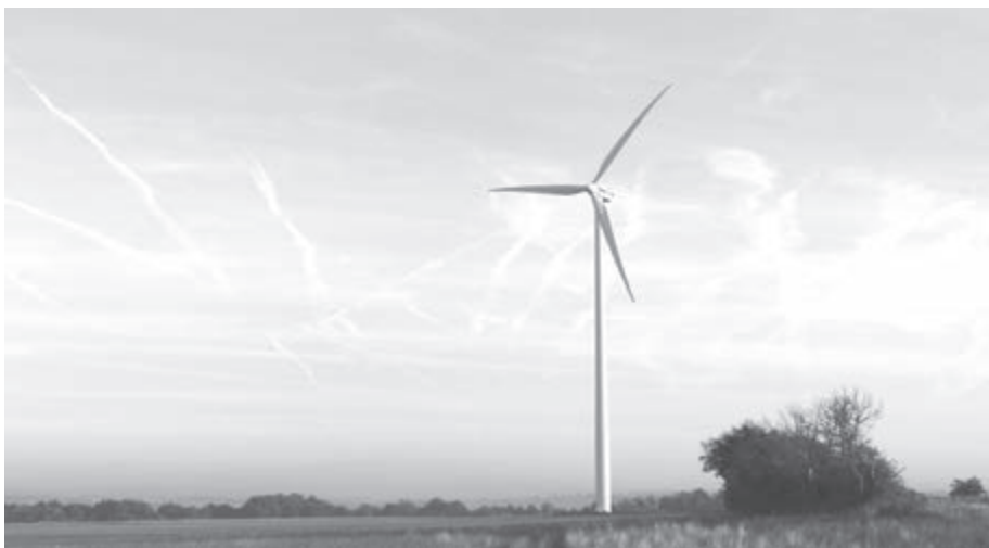
La CDNPS est la commission départementale chargée de donner un avis sur les projets éoliens. (Photo : S. Caux)
