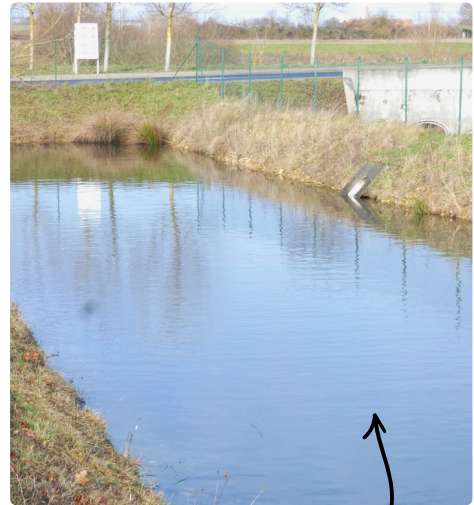
Bassin de rétention à Saint-Maur
