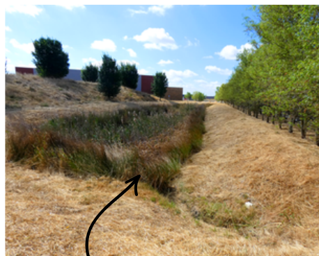
Noue de grande dimension sur le site Natran à Montierchaume
