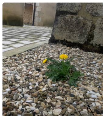
Pied de mur perméable à l'Église de Prissac
